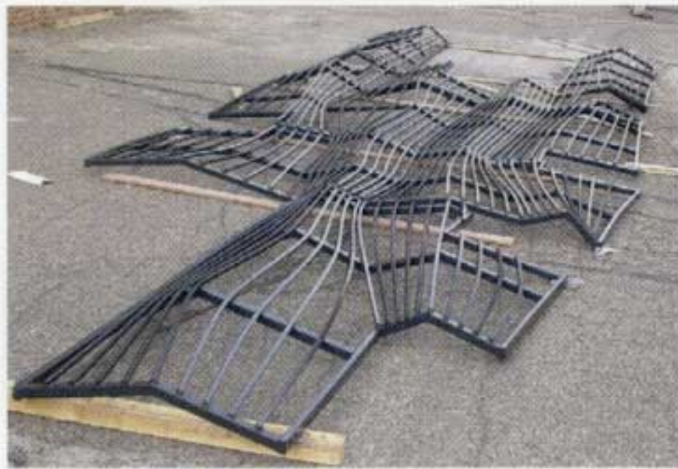
Dekkekonstruksjon under hytta. Floor plate structure.
